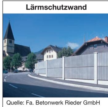
Werden beidseits der Lärmschutzwand Verkehrswege geführt, sind auf beiden Seiten der Wand hochabsorbierende Oberflächen zu empfehlen.
