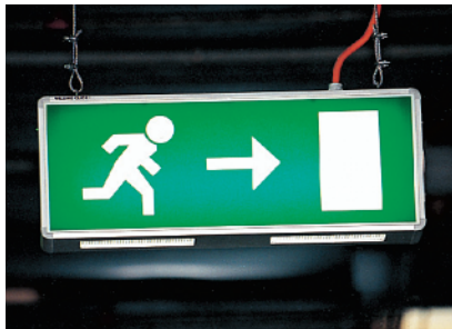
Rettungszeichen „Rettungsweg – Notausgang“ als Leuchtzeichen
