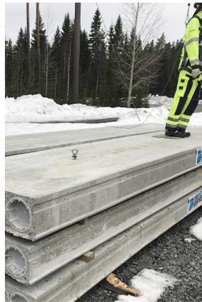
*Oder mit Anker im Fertigteil*
